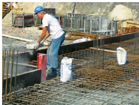
Hydroizolacja spodu płyty fundamentowej, Katowice
