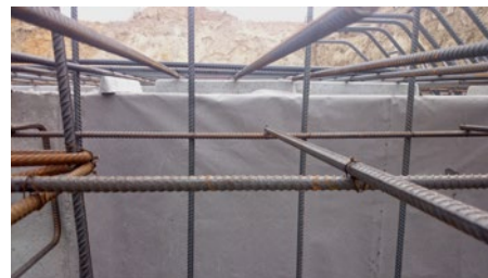
Fot. 2: Uszczelniona Matą Penetrującą powierzchnia ściany pokrywanej betonem.
