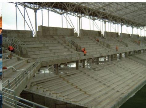
Hydroizolacja elementów betonowych korony stadionu, Kielce
