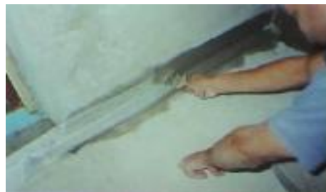
Fot. 2. Uszczelnienie pasem szerokości 12cm styku płyty tarasu ocieplanego ze ścianą.
