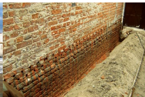
Odtworzenie izolacji pionowej i poziomej, Białobrzegi
