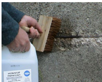
Fot. 1. Nasączenie betonu wokół pręta posiadającego zbyt małą otulinę. Po zabiegu nasączenie będzie wykonana reprofilacja powierzchni.
