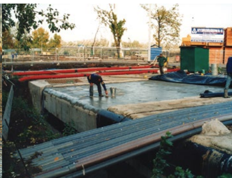
Hydroizolacja wierzchu stropu tunelu świętokrzyskiego, Warszawa
