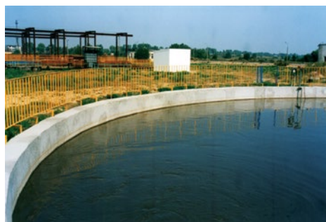
Hydroizolacja oczyszczalni ścieków, Bielsk Podlaski
